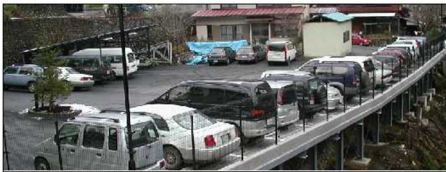
工事終了後の駐車場
